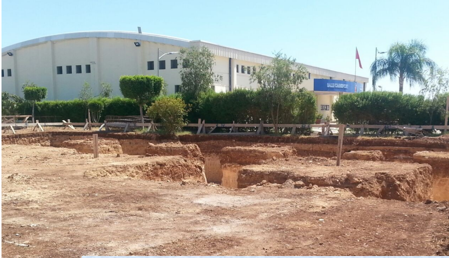
انطلاق أشغال بناء معهد علوم الرياضة
